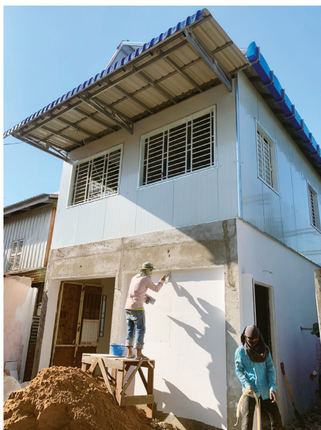
第三宿舍新建工程
